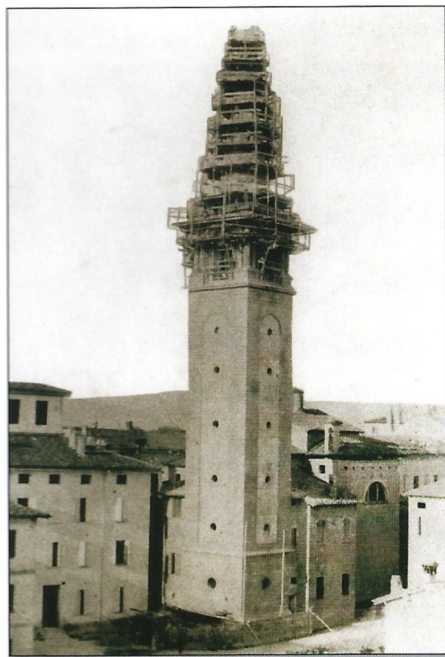
1890. Sostituzione della guglia.
