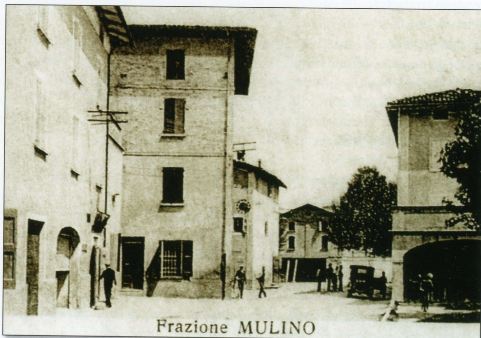
La frazione Mulino, all'inizio della Via Magazzeno, negli anni Venti. La sede comunale di Savignano si trovava nell'edificio a destra. (Archivio M. Domenichini)
